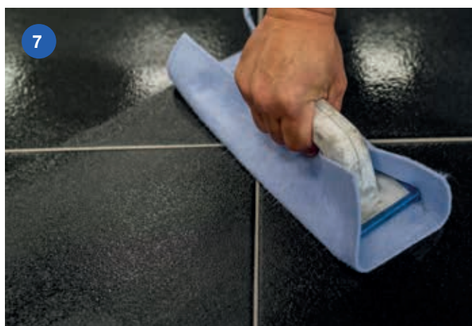
Slike 4, 5, 6 i 7: Za čišćenje svježih ostataka cementnih masa odmah nakon fugiranja preporučujemo sredstvo ULTRACARE KERANET EASY .
