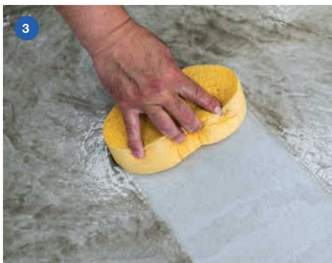
Slike 1, 2 i 3: ULTRACARE KERANET, sredstvo na bazi kiseline, efikasno uklanja stvrdnute ostatke cementnih masa za fugiranje, ljepila, glet mase i sl. s površina otpornih na kiseline.
