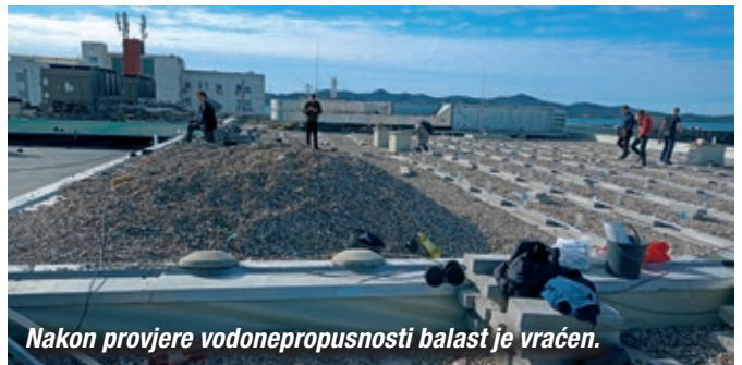
Krov tijekom izvođenja radova i dio s izvedenom hidroizolacijom.
