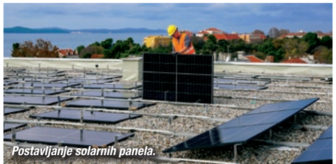
Nakon provjere vodonepropusnosti balast je vraćen.
