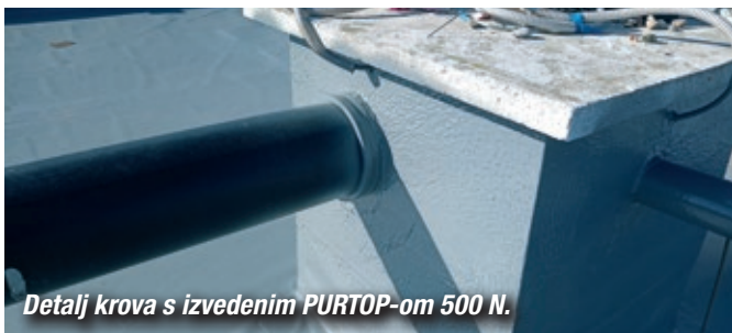
Nosivi sloj hibridne poliuree PURTOP 500 N nanesen je strojno 30 minuta nakon sazrijevanja temeljnog premaza pri temperaturi materijala između +65°C i +85°C i tlaku 160 – 200 bara.
