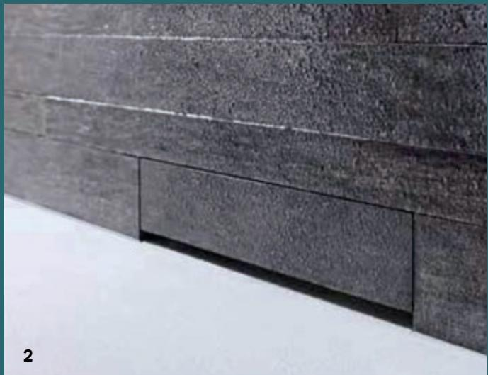
1 Diskretan i vrlo jednostavan za čišćenje. 2 Poklopac zidnog odvoda je također moguće prekriti pločicom kako bi se uklopio u dizajn kupaonice.
