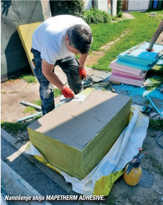
Termo-izolacijske ploče zalijepljene su cementnim mortom MAPETHERM ADHESIVE te dodatno pričvršćene mehaničkim pričvrscicama MAPETHERM STR-U.
