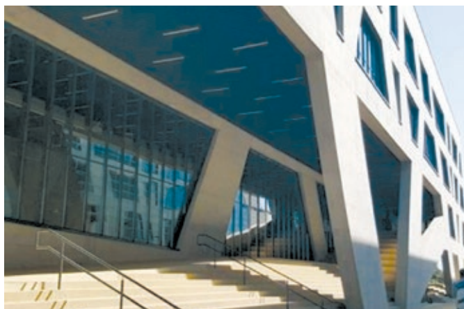
Izgled objekta s fasadnim panelima od prаног betona (lijevo) i detalj elementa od prаног betona (desno)
